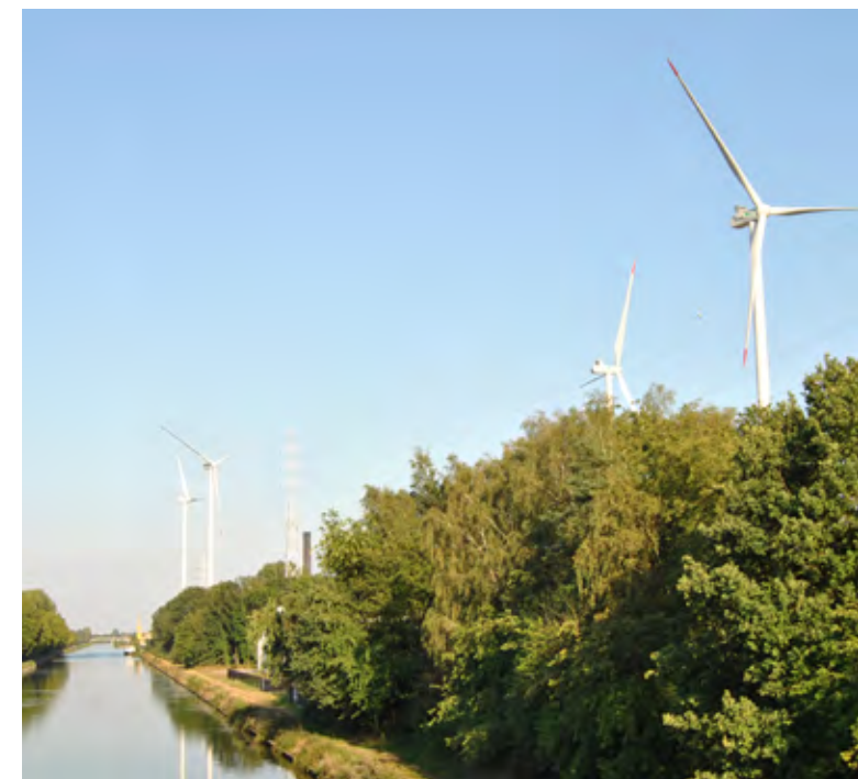
Windkraftanlagen versorgen das Aurubis-Werk Olen
